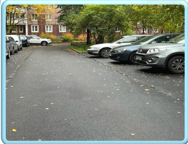
Покрытие внутриквартальных проездов
